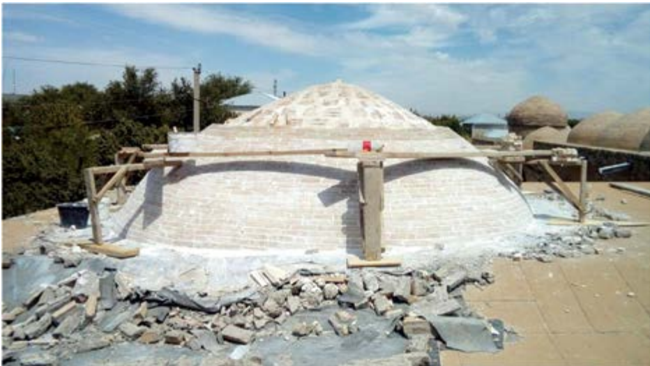
3-сурет. Аппақ Ишан архитектуралық кешенінде темірбетон тақталарын және қарсыкөрмелерді орнату жұмыстары
